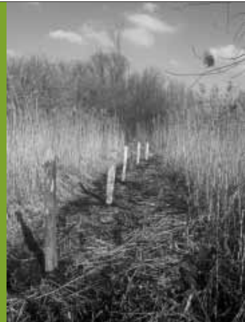
Photo : V. Swinnen, pose de clôtures aux Près de Grand Rieu
