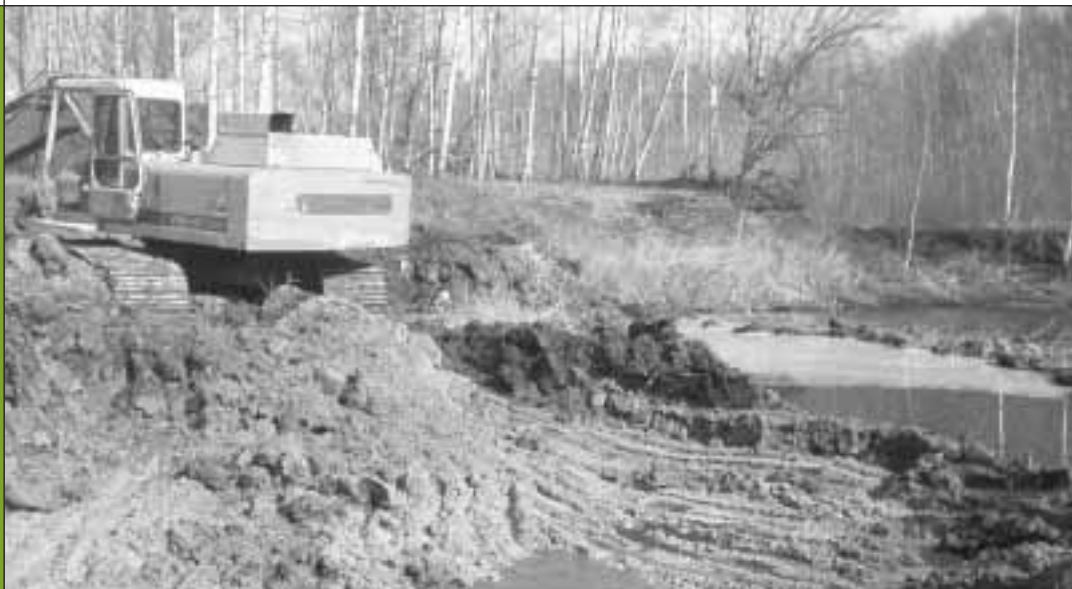
Photo : P. Dupriez, travaux d'agrandissement
