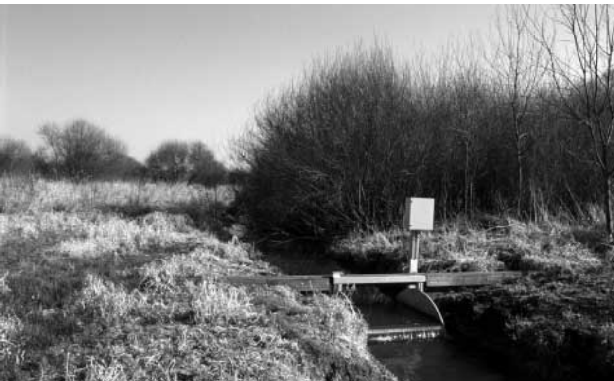
Photo : V. Swinnen, construction d'un moine au marais de Douvrain
