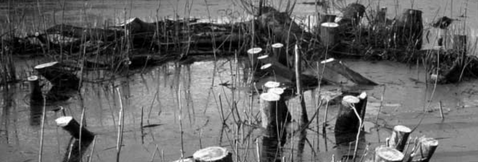
Photo : V. Swinnen, travaux de déboisement à Hautrage
